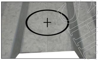
3. 依據鋼承板落水頭用之裁切孔尺寸表描繪切割 預留孔。
