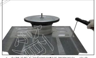
6. 在鋼承板上並和固定配件焊接固定。完成。 (也可採用自攻螺栓或攻牙固定之)
