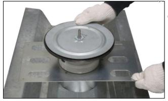
5. 取用預先組裝完成 2.的落水頭組合並置入預留 孔鋼承板位置。
