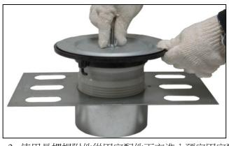
2. 使用長螺桿附件從固定配件下方進入預定固定配件並使用附件保護蓋及蝶型螺帽預先固定拴緊落水頭本體。
