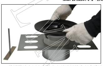
1. 將導管放上固定配件上方並放置落水頭本體於其上。再來使用長螺桿附件插入預定位置。
